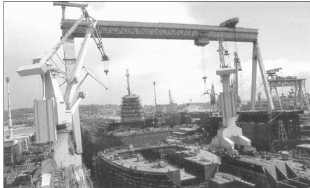
Портовые сооружения судовой верфи «Гдыня»
